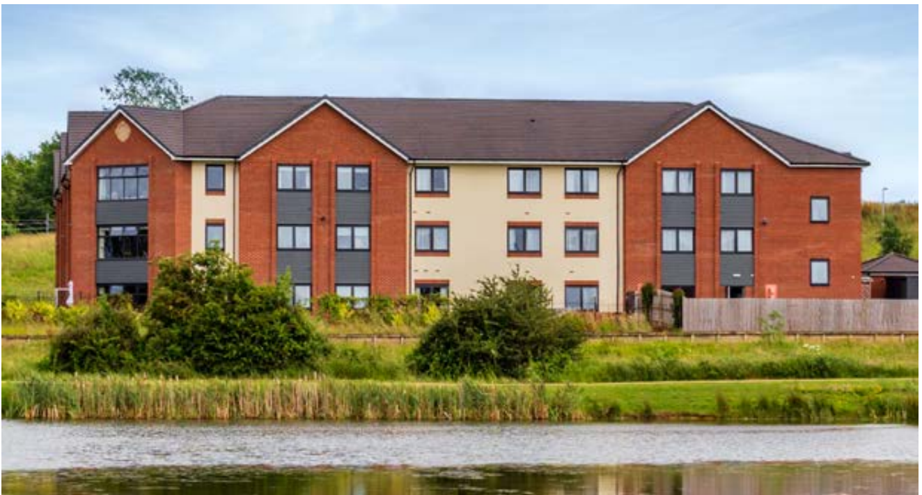
► Maison de repos et de soins – Milton Keynes (UK)
