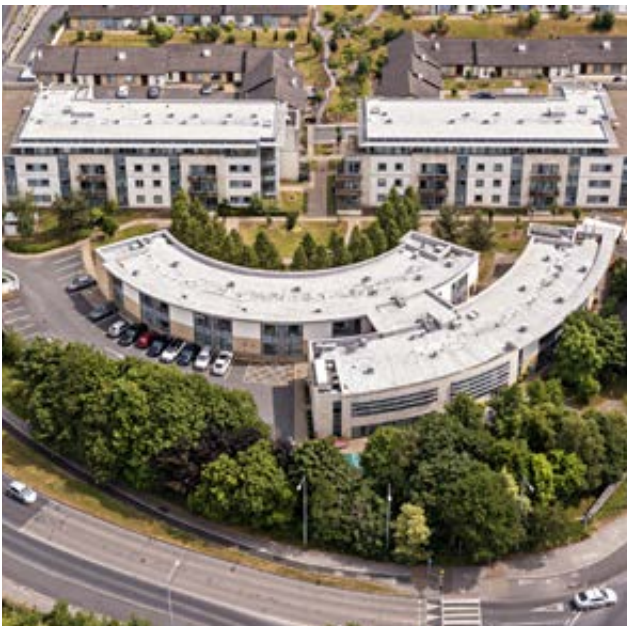
► Vue aérienne de la maison de repos et de soins - Limerick (IE)
