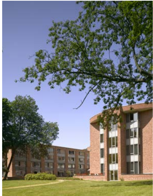
► Maison de repos et de soins Paloke - Bruxelles (BE)
