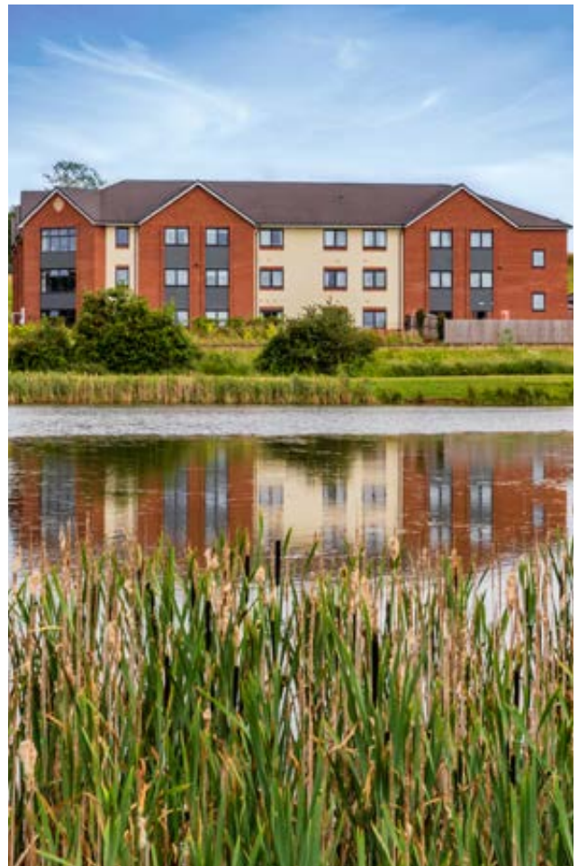
► Maison de repos et de soins – Milton Keynes (UK)
